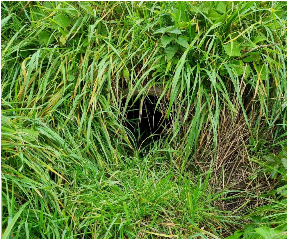
Abbildung 4: Verrohrung des namenlosen Grabens innerhalb des Plangebiets (24.10.2023)
