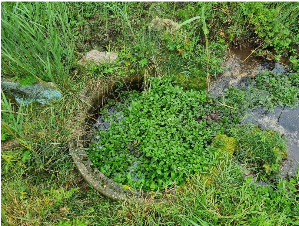
Abbildung 5: Durch den Einsatz eines Betonrohrs wird der Graben leicht angestaut (24.10.2023).
