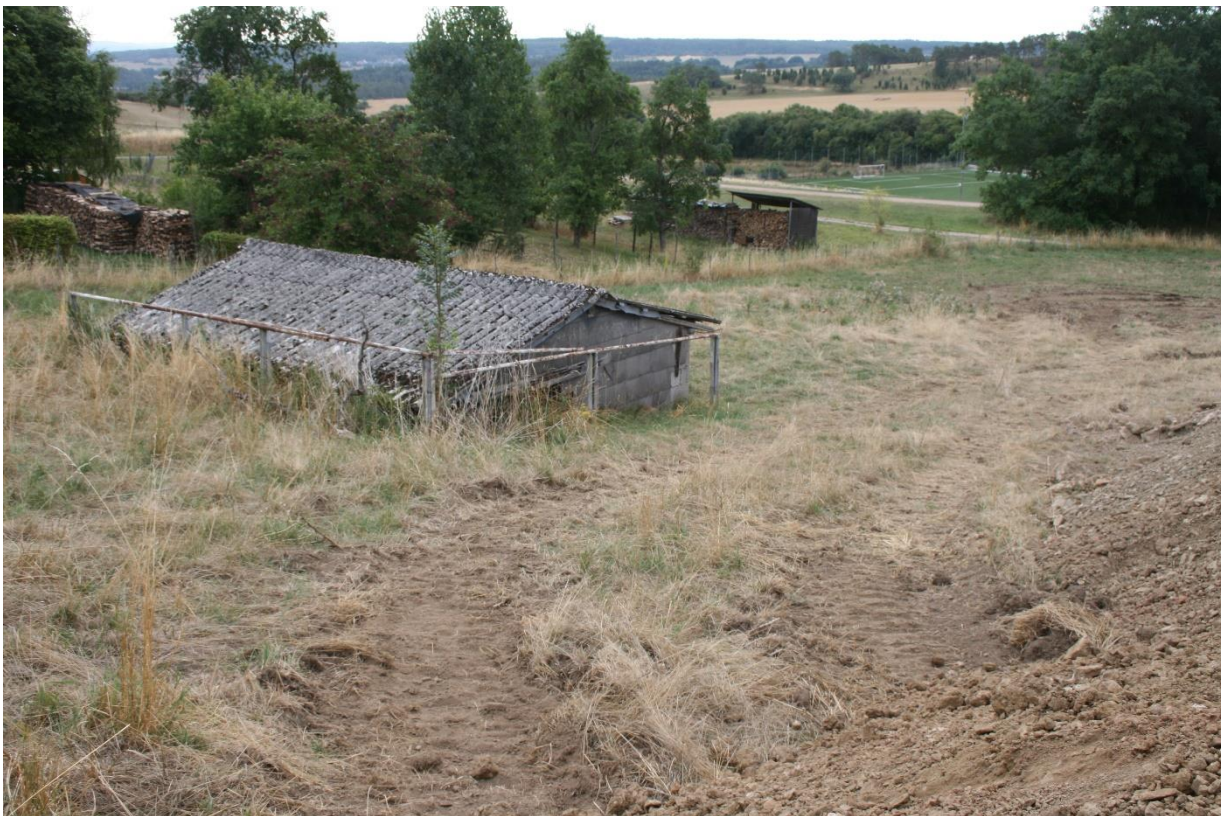
Abbildung 16: Der moderne Hühnerstall, Nord und Südseite des Gebäudes sind teilweise unter der Anschüttung begraben.
