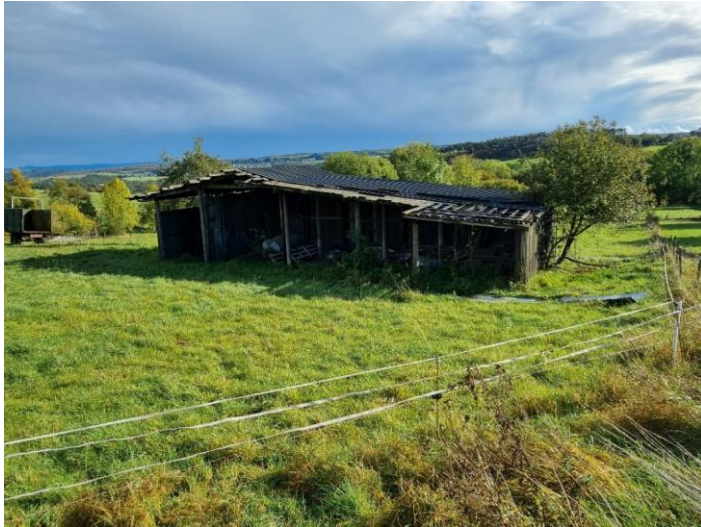
Abbildung 5: Blick auf den offenen Unterstand im westlichen Teil des Plangebiets
