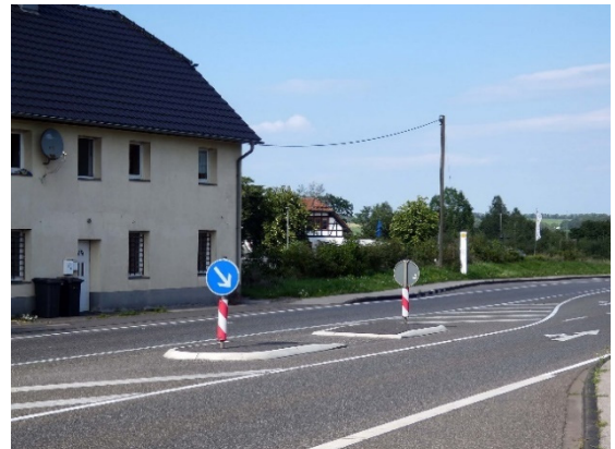
Straße Mülheimer Haus, Haus Nr. 4, Querungssicherung
