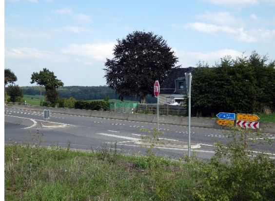
Einmündung nördlicher Ast Straße Mülheimer Haus mit innenliegendem Linkseinfädelungsstreifen
