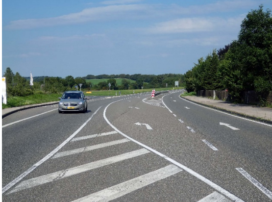
Rechtsabbiegefahrstreifen mit anschließendem innenliegendem Linkseinfädelungsstreifen
