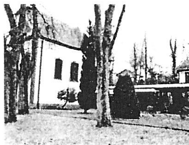
Unmittelbar hinter der Kapelle steigt das Gelände noch ca. 8 m an und ist bebaut (Kindergarten mit Nebengebäuden)
